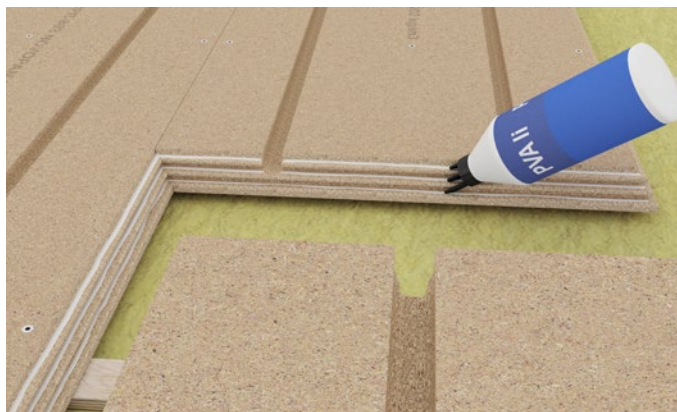
Figur 6 Lim på strøer og på alle tre fer-oversider.
